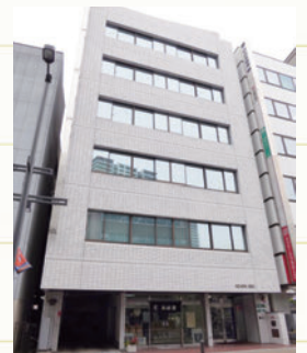
1983年、もらい火で店舗を焼失して建て替えられた木崎屋ビル。2004年、OAフロアに対応する大改修で、現在の姿に。
