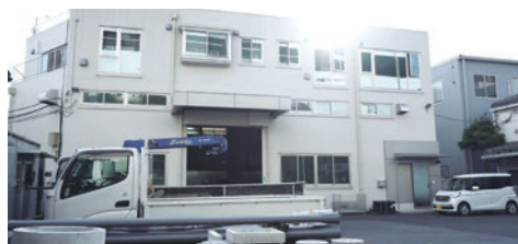
与野イオンに隣接する社屋。資材はすべてここで搬入・搬出され、県内や東京の現場に運ばれていく。
