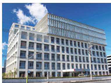
安心な暮らしを守る警察署など、多くの公共施設の電気設備工事を受注している。
